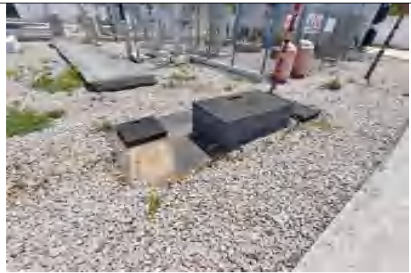
一体化污水处理设施
