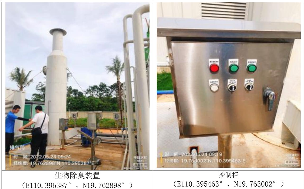
图 3-3 生物除臭装置照片
